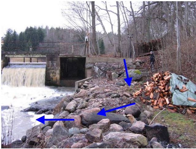
Figur 20. Åtgärdsobjektet från en vy nedströms, pilarna visar den tänkta sträckningen på ett kort omlöp eller trappa. (Foto: T. Nydén).
